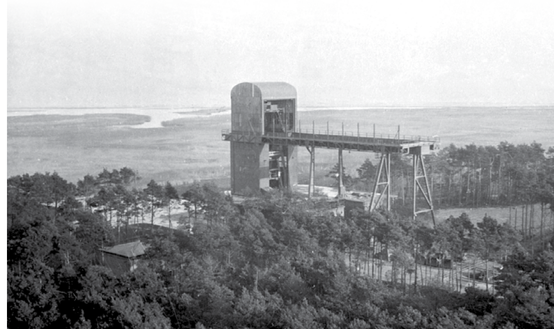
Virš pušynų kylančios bandymų stendo Nr. 1 (P-1) konstrukcijos.
